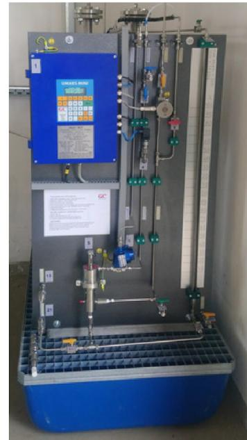
Jádrem odorizačního zařízení typu PD je pneumatický dávkovač WILLIAMS. Toto zařízení je samonasávací a nepotřebuje přídavnou energii pro sání odorantu z nádrže. Celý systém odorizačního zařízení je těsný a vyrobený z materiálů, které zaručují spolehlivost zařízení a zároveň vylučují jakýkoliv únik a netěsnost systému.
