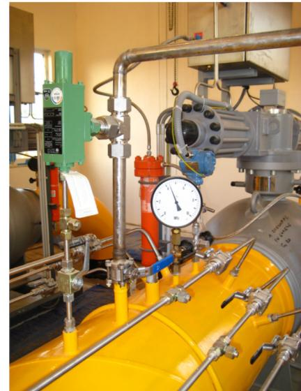
Základním požadavkem rekonstrukce PS byla modernizace celého vybavení s dálkovým řízením celé stanice z oblastního dispečinku bez stálé obsluhy PS. Firma GASCONTROL, společnost s r.o. , co by generální dodavatel, se podílela na výstavbě komplexu vzájemně provázaných zařízení, která umožňují bezobslužnou, dálkově řízenou, regulaci zemního plynu do VTL plynárenské sítě.
