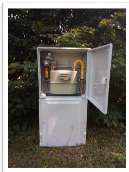
Skříň S 367 pro HUP + podstavec rozměr: 595 x 536 x 205 mm
